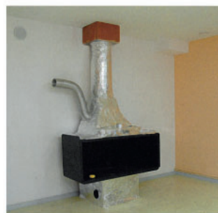
Isolation et raccordement des gaines de sortie d'air chaud
