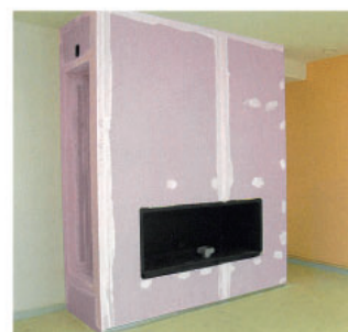
Finition de l'habillage avec une niche et sortie d'air chaud
