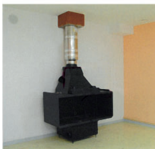
Pose du foyer préassemblé et raccordement au conduit
